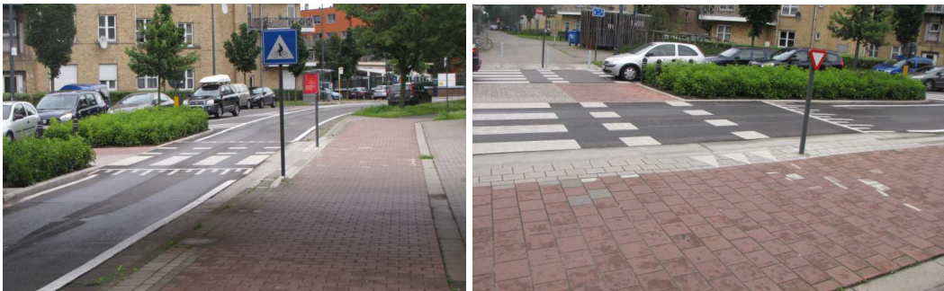
Foto's: Fietsoversteekplaats in de Jan Delvinlaan in Gent. Fietsers moeten voorrang verlenen. De oversteek is verhoogd en duidelijk aangegeven.
